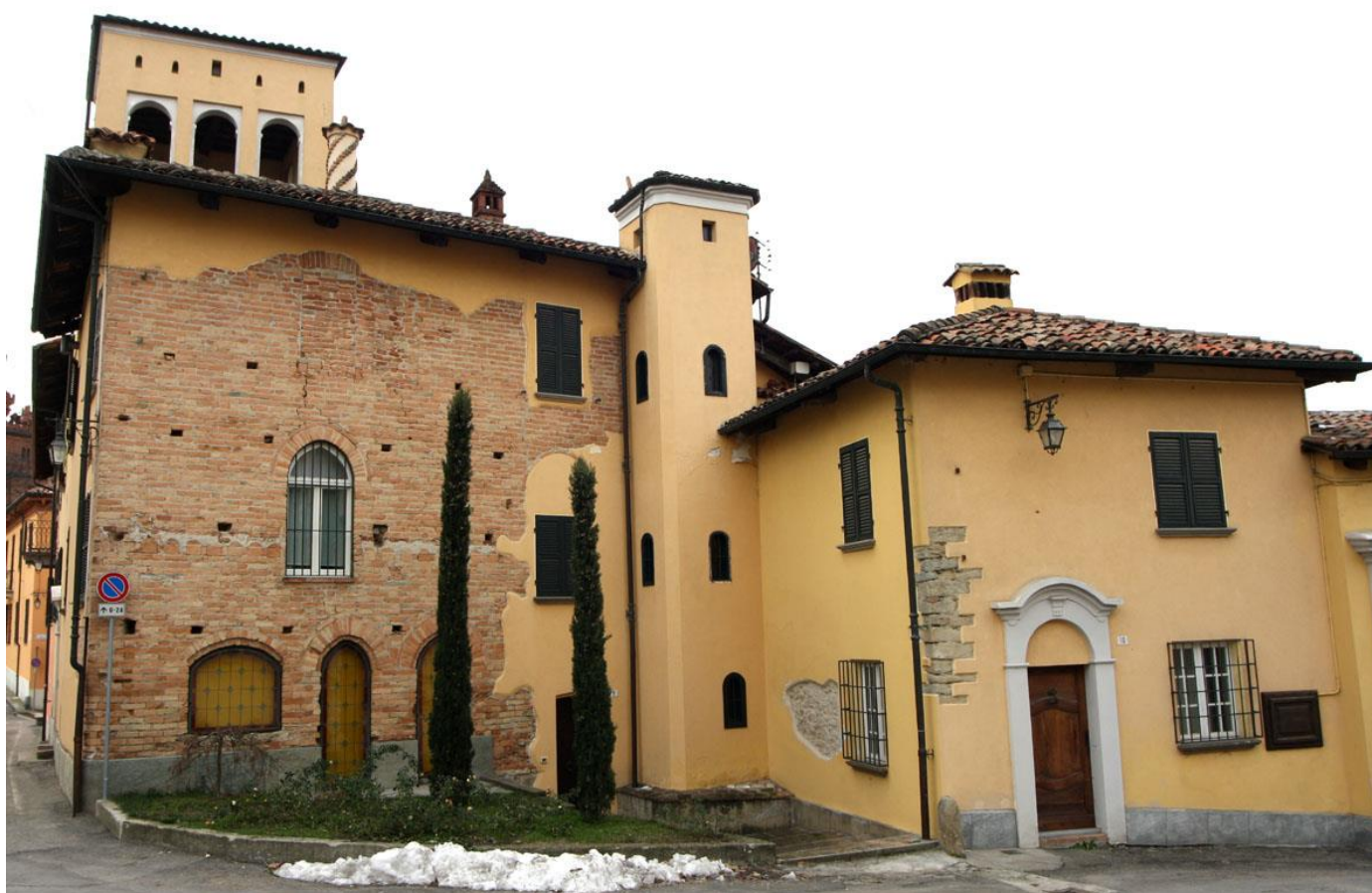
Edificio ben inserito ma con necessità di interventi modificativi riguardo alla finitura della facciata, troppo frammentaria
