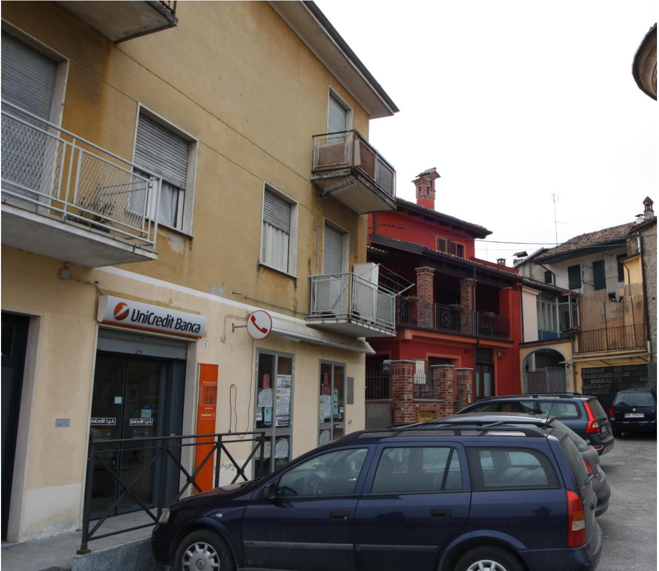
Facciata recuperata in modo scorretto
