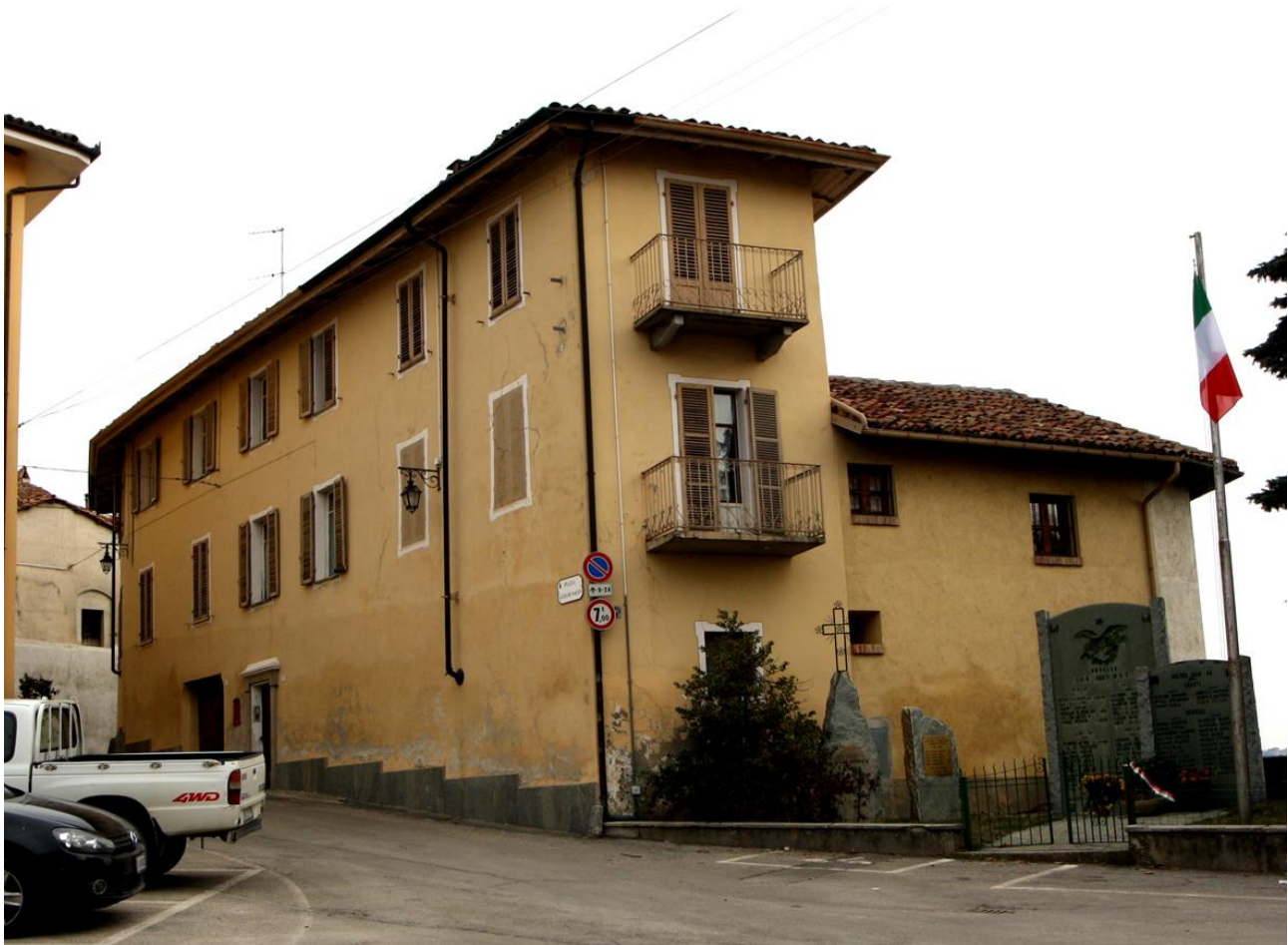
edificio di categoria 3
